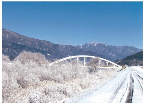
㉕駒見大橋
