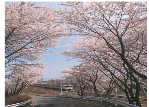
⑱中田切川鉄橋
